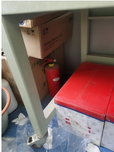
理科楼 A801-803—灭火器未配置架子、无点检记录卡；接线板悬空使用；负责人王卓然（复查新增）
