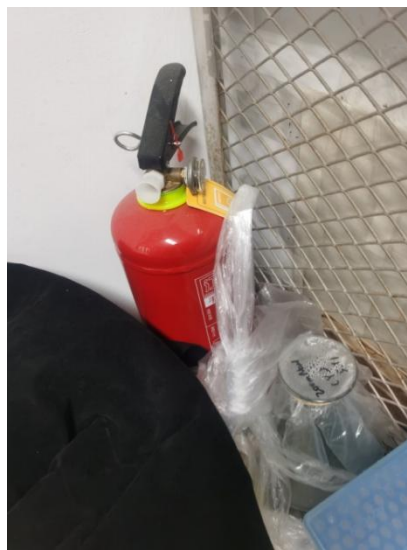
理科楼 A812—接线板超负荷且直接放置地面使用，灭火器未配置架子、无点检记录卡，负责人董世楠（复查新增）
