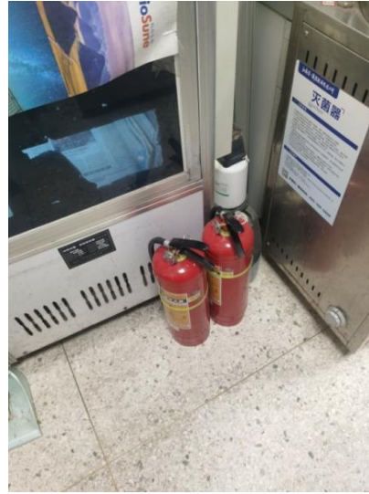
理科楼 A123—灭火器未配置架子、无点检记录卡，负责人刘康（左图为初查，右图为复查）
