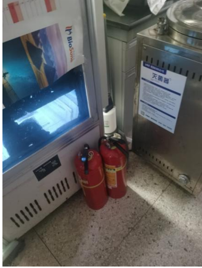
理科楼 A123—灭火器未配置架子、无点检记录卡，负责人刘康（左图为初查，右图为复查）
