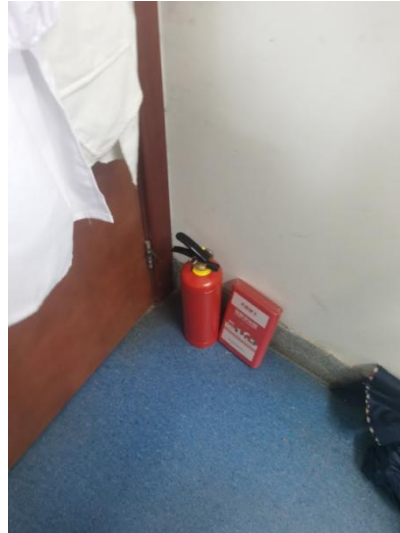
理科楼 A501-503—矿泉水瓶子未撕去原标签；灭火器未配置架子、无点检记录卡，负责人张文伟（复查新增）
